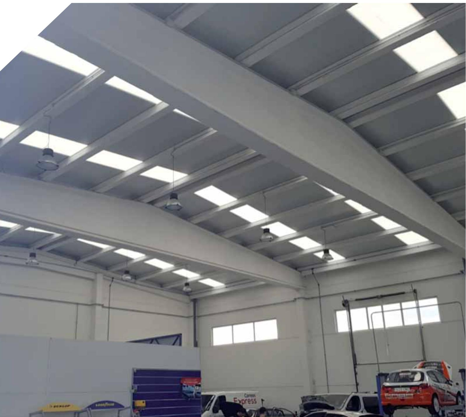
Las vigas deltas son un elemento estructural para la sustentación de cubiertas a dos aguas. Según su luz se fabrican distintos modelos y cantos, siendo la pendiente del 10 o 15 % dependiendo de la longitud del elemento. Éstas pueden llegar hasta más de 40 metros.
