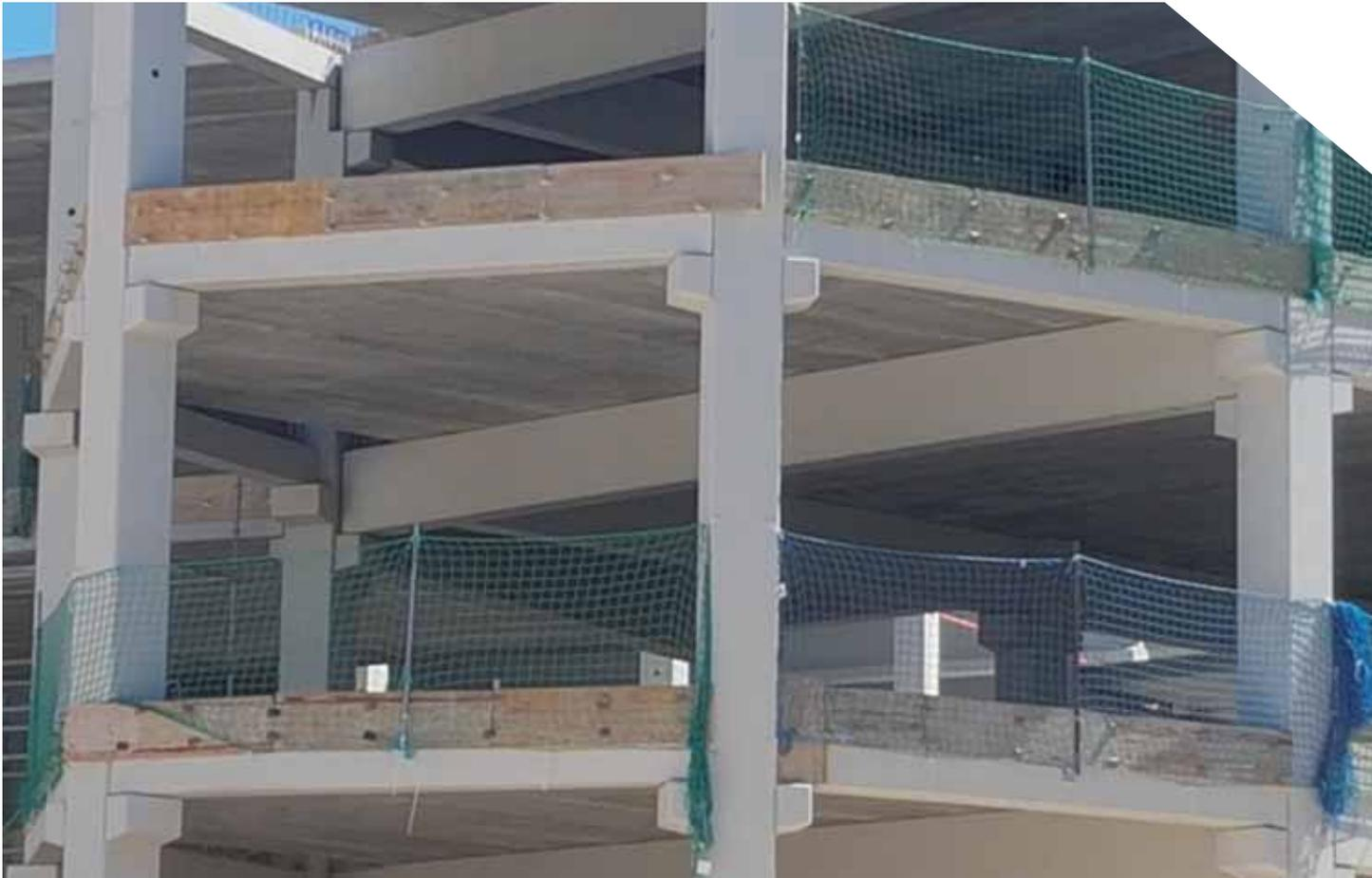
Nuestras jácenas pretensadas y armadas son para dar apoyo a forjados. Las vigas se calculan para cada proyecto, adaptándose a las cargas y luces propuestas. Las jácenas extremas de forjado se pueden fabricar con balderas laterales que reducen considerablemente la cantidad de encofrado en obra, minimizando así los costes de ejecución.
