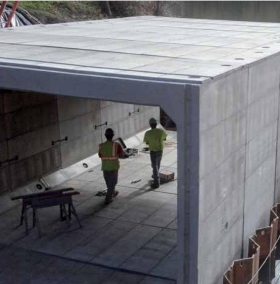
El marco es una pieza autoresistente de hormigón armado que mediante su disposición en forma de galería, consigue ejecutar con rapidez pasos para animales, pasos inferiores peatonales, canalizaciones hidráulicas, colectores de drenaje, galerías de servicios (electricidad, agua, gas, telecomunicaciones, etc.) pasos para pequeños vehículos bajo calzadas, vías de ferrocarril y aeropuertos.
