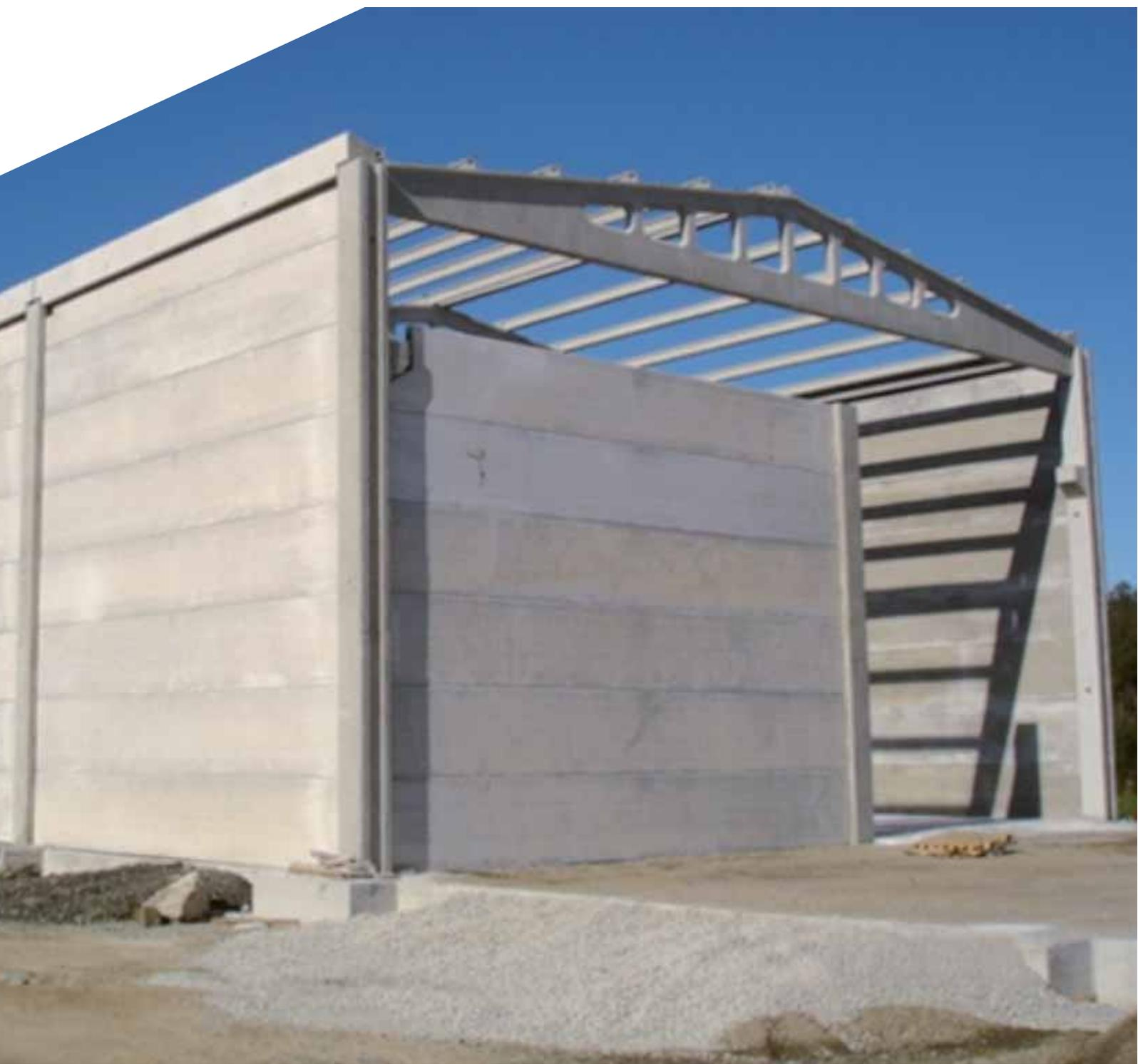
El panel alveolar pretensado constituye una solución ideal como elemento de cierre en fachadas de naves industriales y edificios singulares. Pueden colocarse vertical u horizontalmente en función de las exigencias del proyecto.
